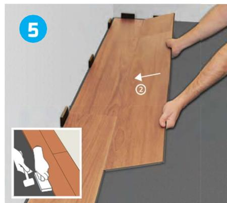
Deslize as peças e encaixe na fila que já se encontra instalada (2). Recomenda-se a utilização de um martelo de borracha e um taco de impacto, com a finalidade de ajustar correta e perfeitamente umas peças às outras.
